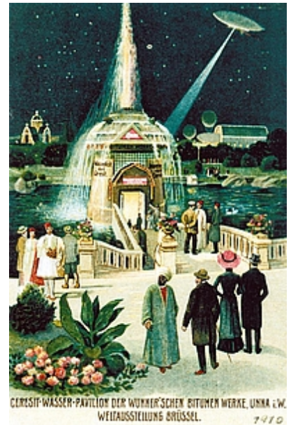
Weltausstellung in Brüssel 1910; 60.000 Liter Wasser pro Stunde prasseln auf den ins Wasser gesetzten und mit Ceresit abgedichteten Zement-Pavillon.
